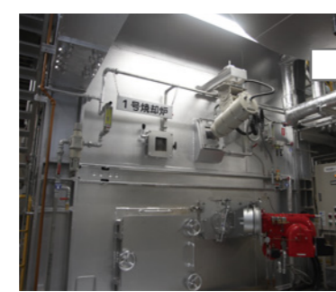
⑦焼却炉 内部はストーカという階段状の床になっており、ごみは、この床が前後に動くことにより、効率良くくぼくされ、850℃以上の高温で完全燃焼します。
