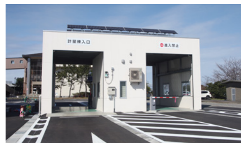
①計量棟 ごみの重量を計測します。
